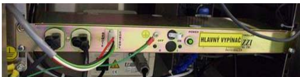
Obr.6. Zadný panel bezpečnostného rozvádzača v zapnutom stave
