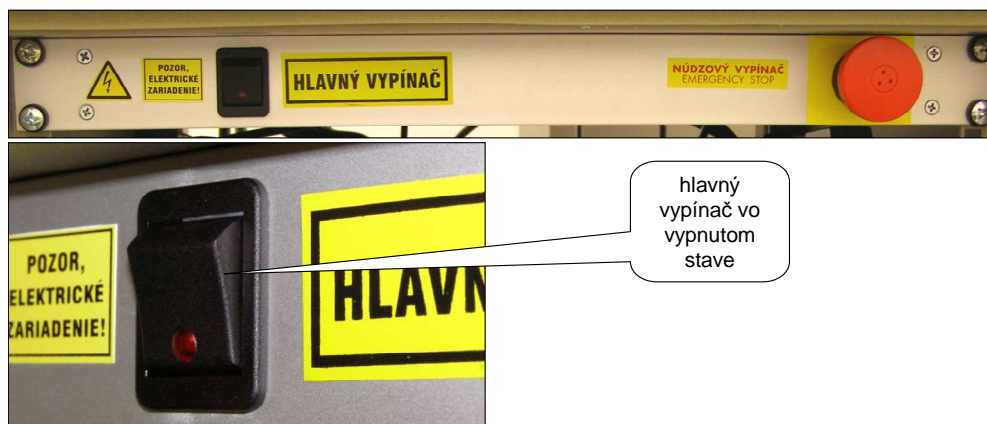
Obr. 3. Predný panel bezpečnostného rozvádzača DC Measurement Racku vo vypnutom stave
